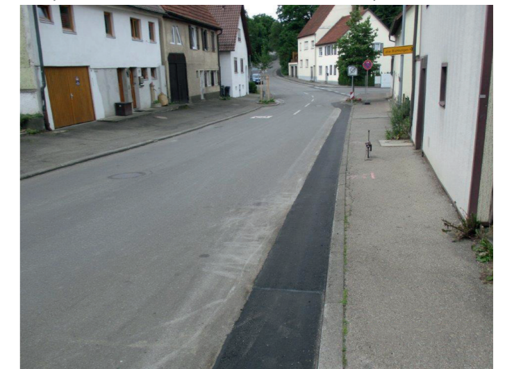
▲ Rückbau der Asphaltschichten
