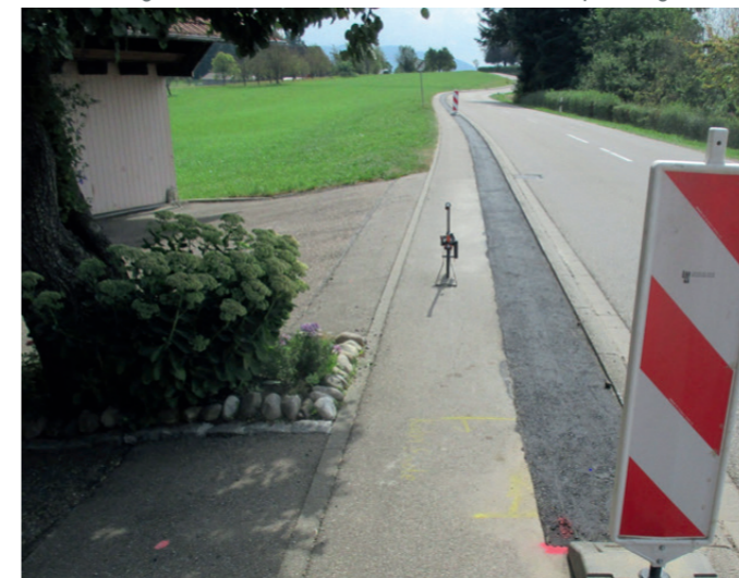
▲ Aushärtung des Verfüllbaustoffs gemäß ZTV
