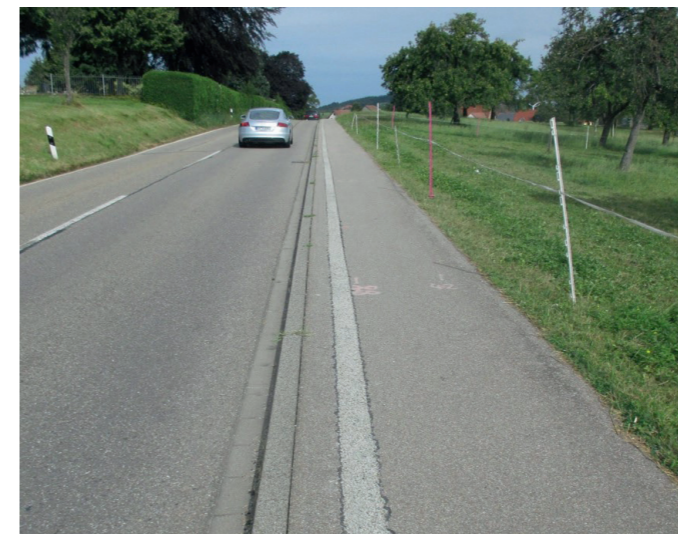
▲ Aushärtung des Verfüllbaustoffs gemäß ZTV
