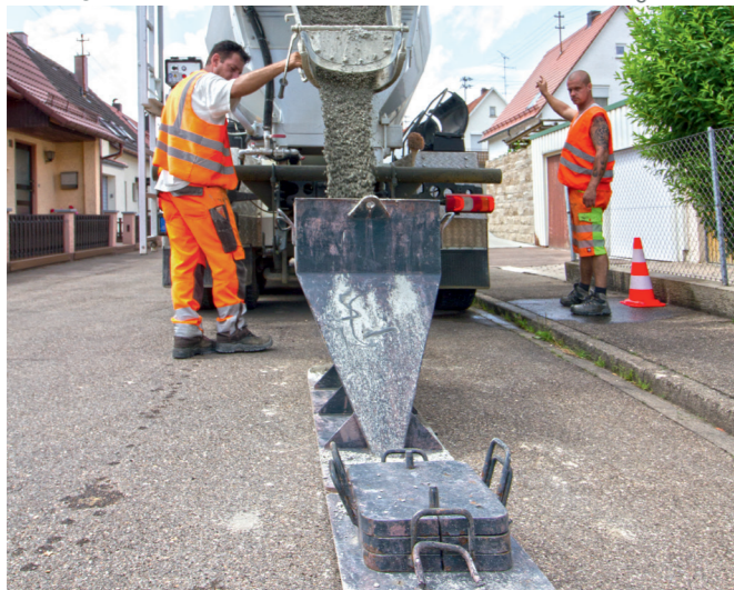
▲ Herstellung des Fräsgrabens
