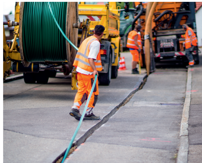
▲ Verlegung der Leerrohre
