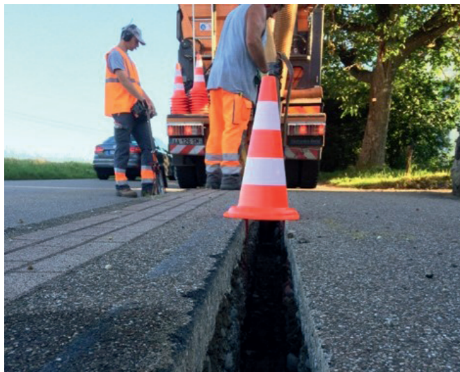
▲ Herstellung des Fräsgrabens
